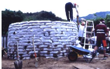
図 4: 土嚢建築施工の様子
